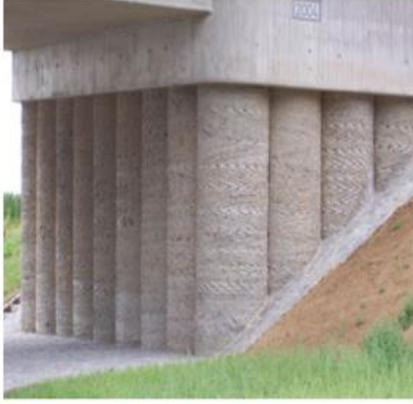
Şekil D.1 Paspayı kalınlığını etkilemeyen düzensizlik gösteren kazıklar için örnekler
