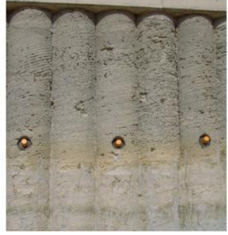
Şekil D.1 Paspayı kalınlığını etkilemeyen düzensizlik gösteren kazıklar için örnekler
