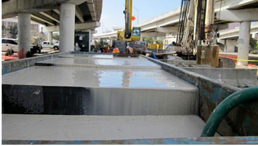
Şekil 5.12 PHPA polimer sondaj akışkan için sedimentasyon tankları
